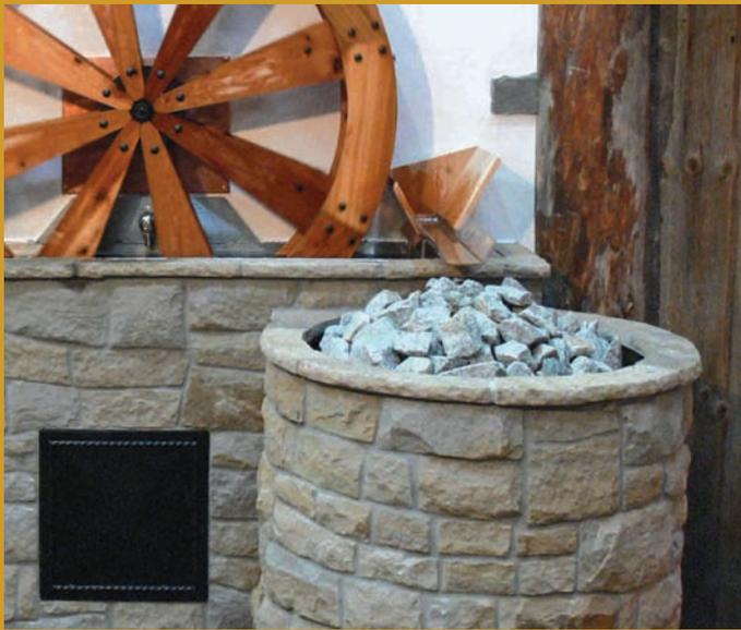
Aus einem Becken schöpft das Mühlrad mit Düften angereichertes Wasser. Über einen Trichter und eine Kupferinne gelangt es zum Ofen. Rhythmus, Geschwindigkeit und Wassermenge steuert dabei modernste Elektronik:
